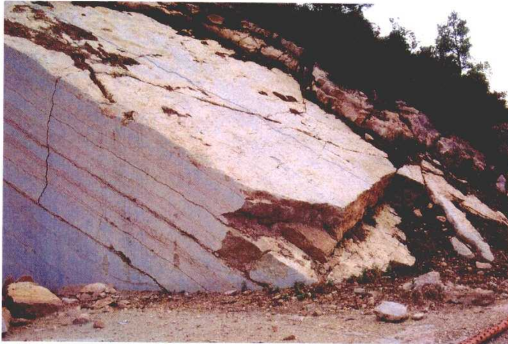
Fotografía 3.1.- Deslizamientos planos a favor de la estratificación en la zona de estudio.
